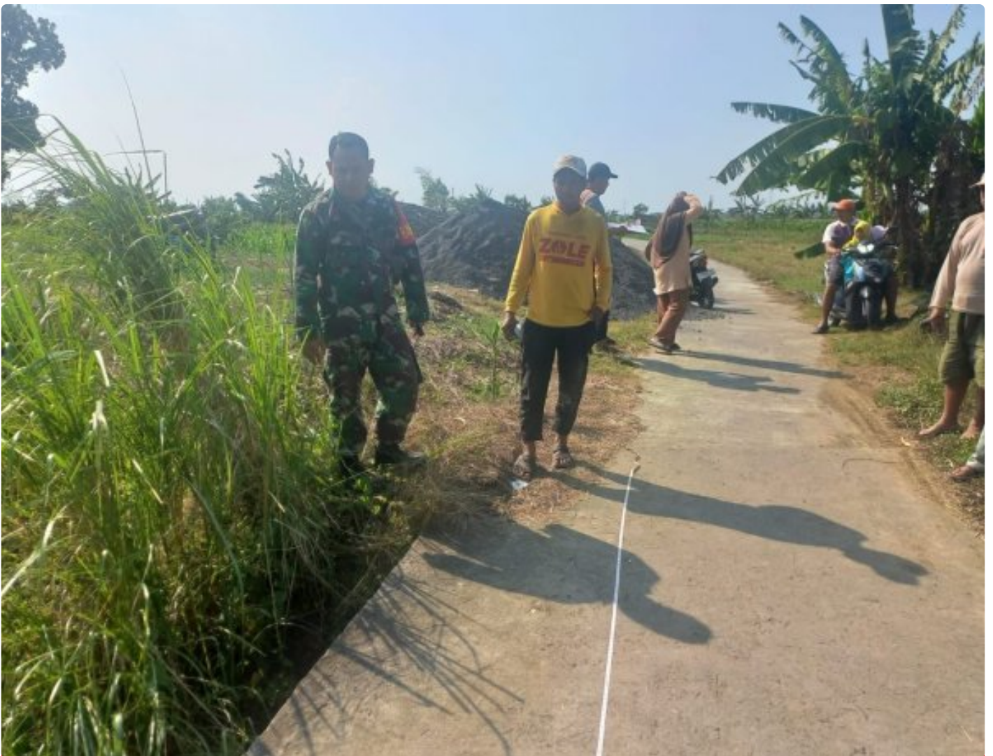
Babinsa Koramil 12/Mranggen, Kodim 0716/Demak Sertu Somyani jalin komunikasi sosial bersama Bapak Ikhsan sebagai pelaksana pembangunan jembatan
